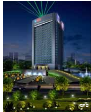
漕湖オフィスビル 室外LED照明器具は太陽電器製を採用（2011年3月） The outdoor LED Lightings of Cao Lake office building are all afforded by Sun Industrial.(Completion Time: March, 2011) 漕湖办公楼户外LED照明由太阳电器提供(完成时间 2011年3月)
