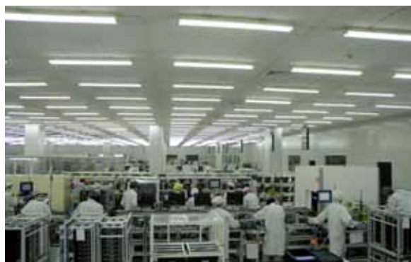
パイオニア上海工場LED蛍光灯切替工事実例 PIONEER TECHNOLOGY(SHANGHAI)CO.,LTD.'s Adopting LED Lightings PIONEER 先锋高科技(上海)有限公司工厂LED荧光灯替
